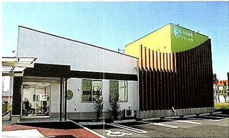
呼吸器科クリニック (愛知県豊橋市)
