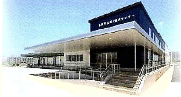
福岡市「第2給食センター」(東区) (導入箇所)揚物・焼物・蒸し物調理室をはじめ、アレルギー専用調理室など全19か所に31台のUVGIが設置されました。
